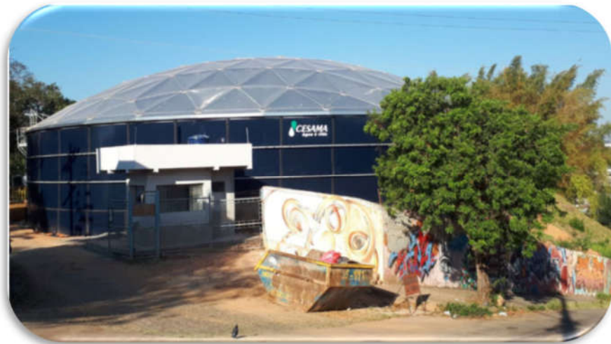
Reservatório Santa Terezinha
