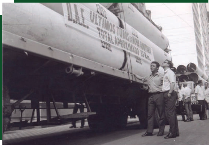
Foto: O diretor do DAE, José Roosevelt Pereira, e o prefeito de Juiz de Fora, Itamar Franco, recebendo a tubulação da Segunda Adutora, em 1970.
