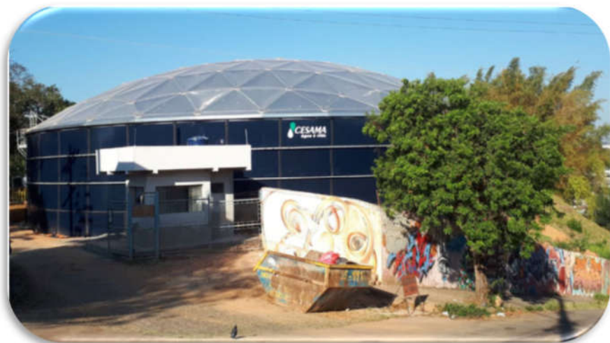
Reservatório Santa Terezinha
