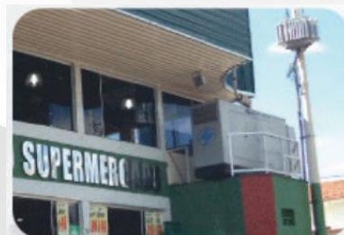
GMG 260 KVA AUTOMÁTICO SUPER SILENCIADO
