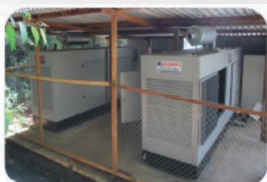
02xGMGs 450 KVA AUTOMÁTICO SILENCIADO
