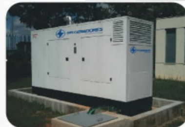
GMG 450 KVA AUTOMÁTICO SILENCIADO
