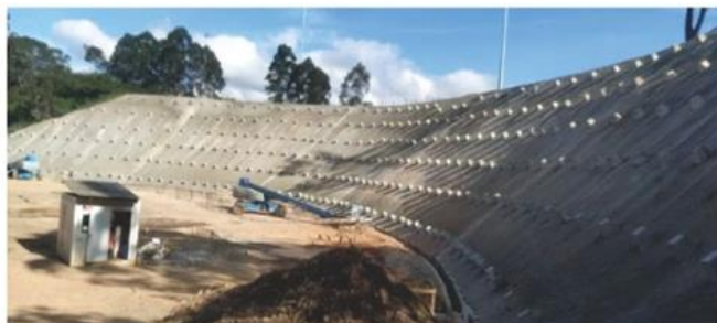
Fiscalização da cortina atirantada - Belo Horizonte, MG
