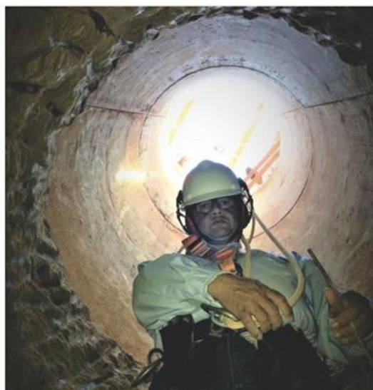
Liberação de base de tubulão - Campinas, MG
