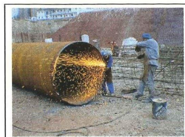
Preparação da camisa metálica
