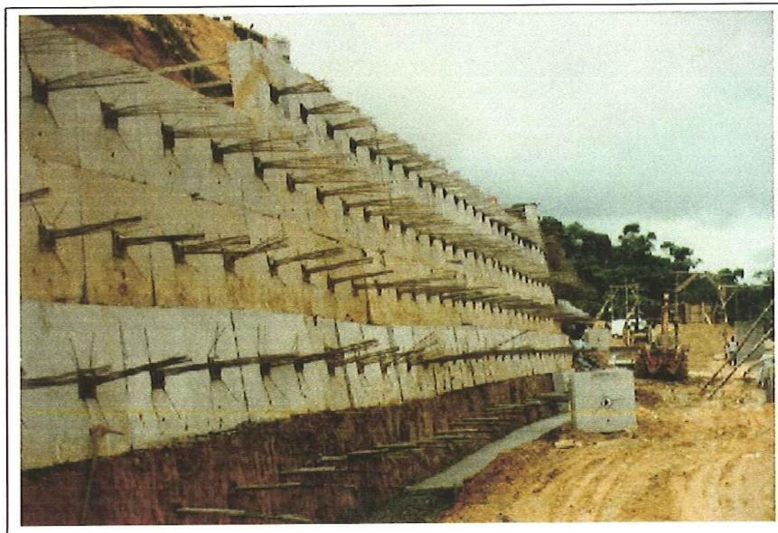
CORTINAS PRÉ-MOLDADAS ATIRANTADAS
