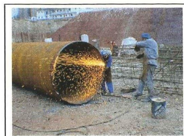
Preparação da camisa metálica
