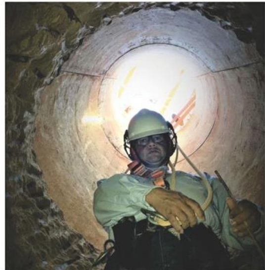
Liberação de base de tubulão - Campinas, MG
