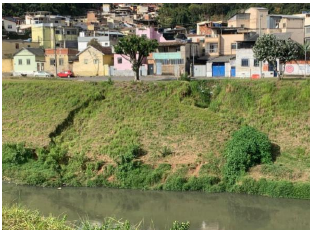
Local da obra
