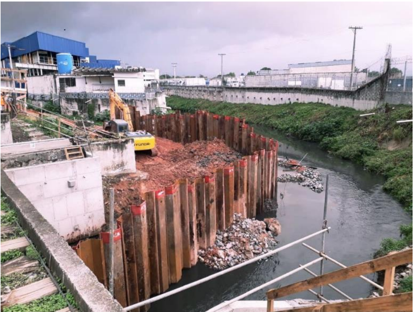
Ensacadeira para garantia da execução da obra
