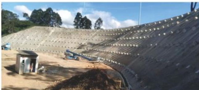
Fiscalização da cortina atirantada - Belo Horizonte, MG
