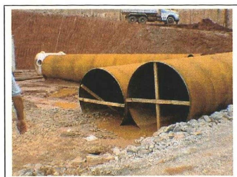
Camisas metálicas utilizadas na obra
