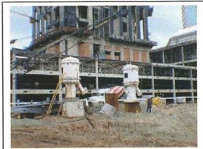
Campânulas de ar comprimido
