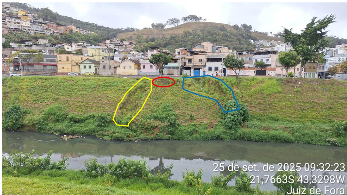
Foto 5 - Vista frontal do talude da margem esquerda do Rio Paraibuna, com indicação de 03 processos erosivos: em amarelo e azul estão indicadas as erosões hídricas que se manifestam na superfície do talude, e em vermelho está indicado local de ocorrência de erosão tubular intestinal (“piping”).
