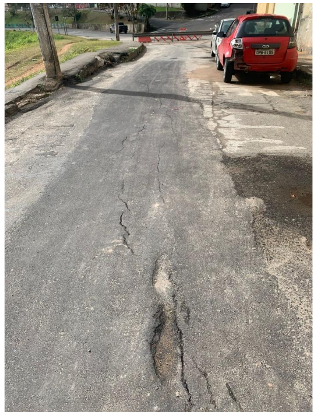
Foto 4-Vista da Av. Brasil, com fissuras e trincas (foto fornecida pela CESAMA).
