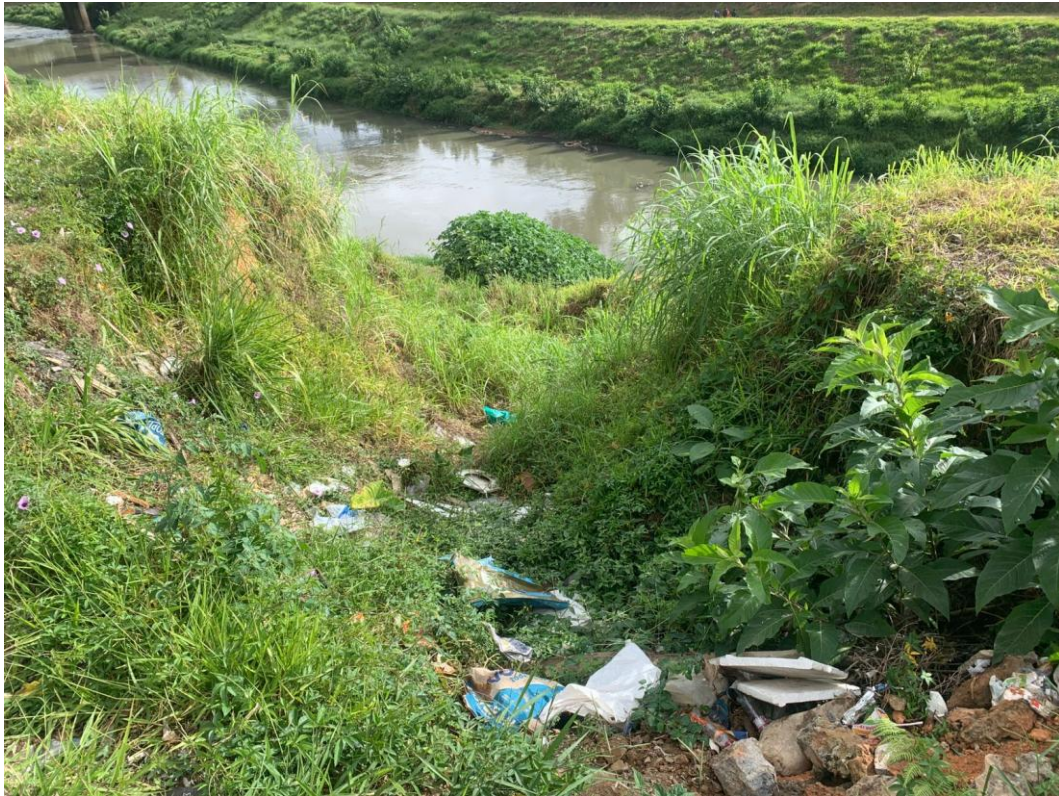
Foto 3-Vista de uma das laterais da possível ruptura (foto fornecida pela CESAMA).
