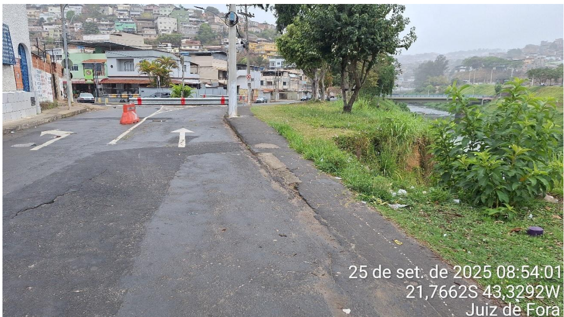
Foto 9 - Erosão hídrica na superfície do talude, indicada em azul na Foto 5. A crista da erosão está muito próxima à Av. Brasil.
