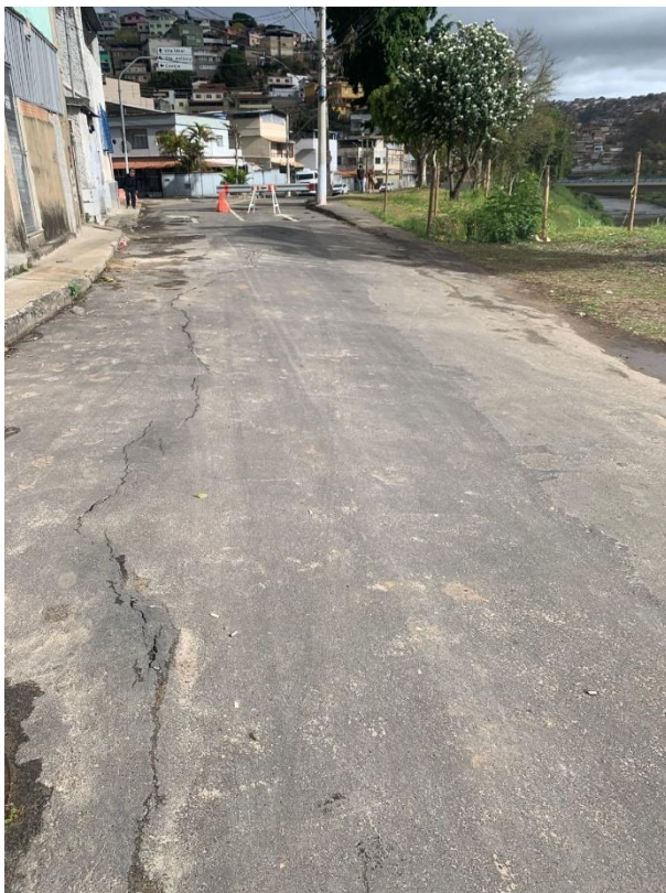
Foto 4-Vista da Av. Brasil, com fissuras e trincas (foto fornecida pela CESAMA).
