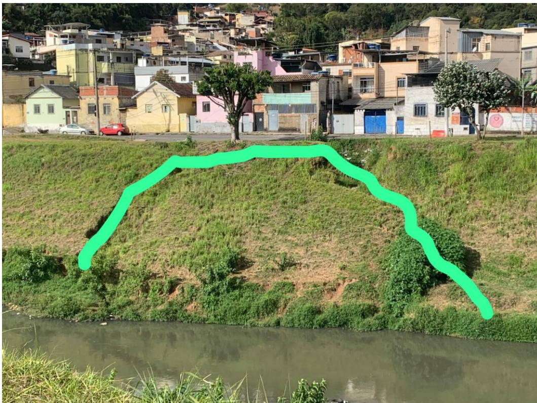
Foto 2-Mesma foto anterior, com indicação da possível ruptura (foto fornecida pela CESAMA).
