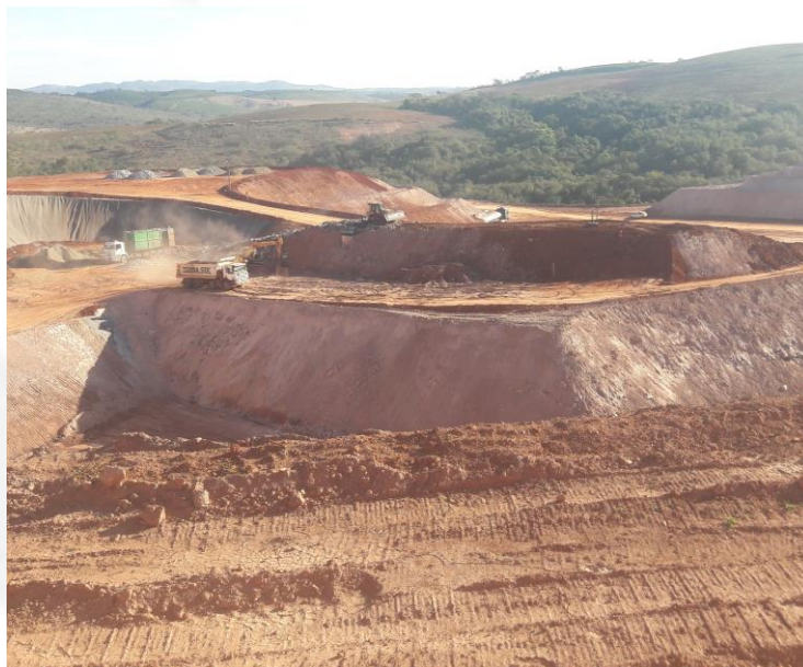
Foto 04. Célula em operação do aterro sanitário
