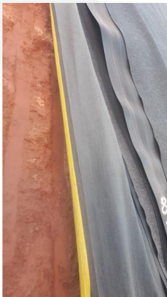
Foto 03. Camadas de impermeabilização
