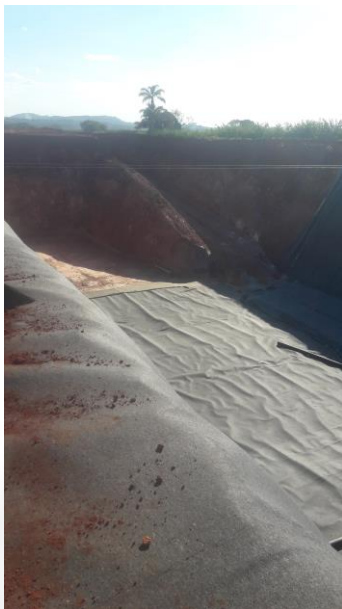
Foto 01. Vala para resíduos classe II
